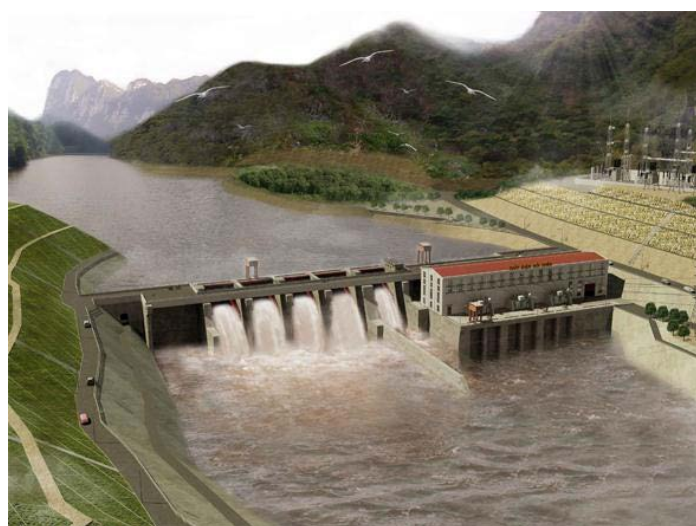
Hình 13: Dự án thủy điện Trung Sơn, xã Trung Sơn, huyện Quan Hóa [4]
