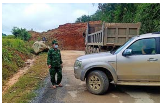
Hình 7: Quốc lộ 15C bị chia cắt hoàn toàn (huyện Mường Lát 19/10/2021)
