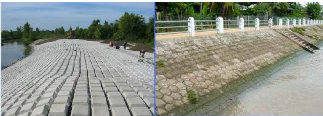
Hình 14: Thảm bê tông liên kết mềm [5]
